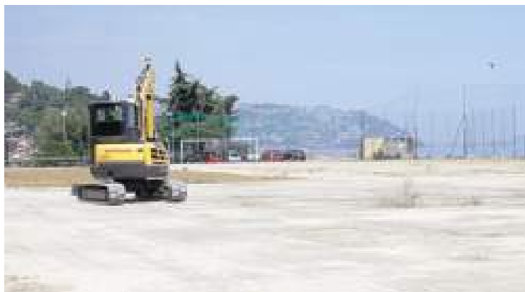
Conclusi i lavori di sistemazione del campo dell'Arziglia
