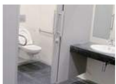
Uno dei bagni ristrutturati
